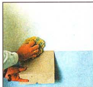
Чтобы не задеть губкой цоколь, его укрывают куском картона.
