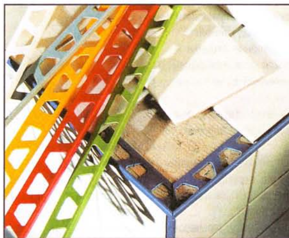
Боковая и задняя стенки бокса собраны из ДСП толщиной 19 мм, а затем облицованы плиткой. Углы облицовки декорированы пластиковыми профилями, перфорированные планки которых уходят под плитки.
