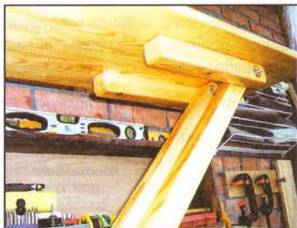
8 Крепление доски к опорам.
