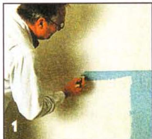
Оклеенную стену окрашивают в желаемый цвет. Можно выделить цоколь, окрасив его другой краской.
